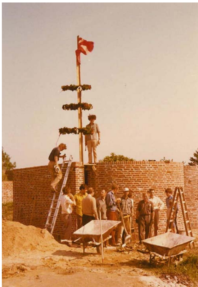
Rejsegilde på Islev Kirkes Ungdomscenters tredje etape
